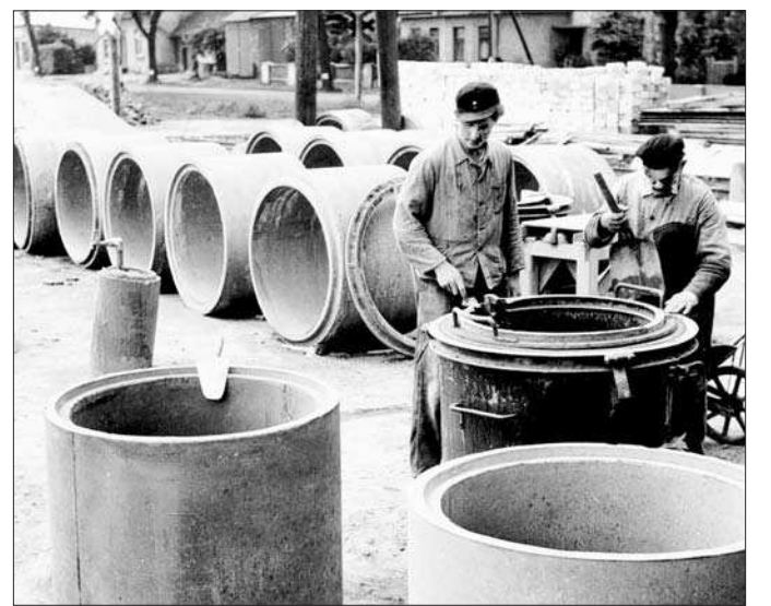
Wann und wo ist dieses Bild entstanden? Es zeigt offensichtlich Arbeiten an der Kanalisation im Wittlager Land, vermutlich in den Jahren zwischen 1955 und 1960. Wer Hinweise geben kann oder sogar die beiden Männer erkennt, sollte sich unter Tel. 054 72/94 3410 an die Lokalredaktion des Wittlager Kreisblattes wenden.
