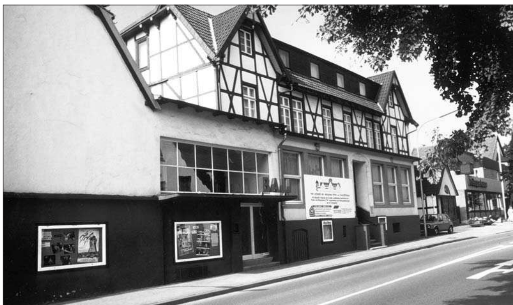
Zu Filmkunsttagen lud 1960 das alte Bad Essener Kino (diese Aufnahme zeigt das Lichtspielhaus kurz vor dem Abbruch) ein. Repros: Wolfgang Hüge
